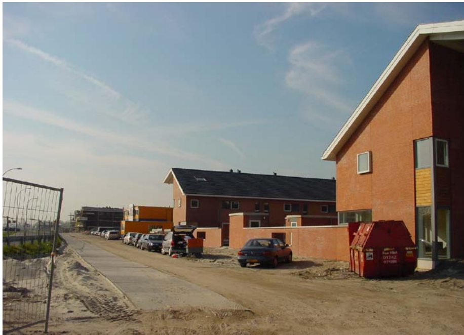
Nieuwbouwwijk 's Gravenhout
